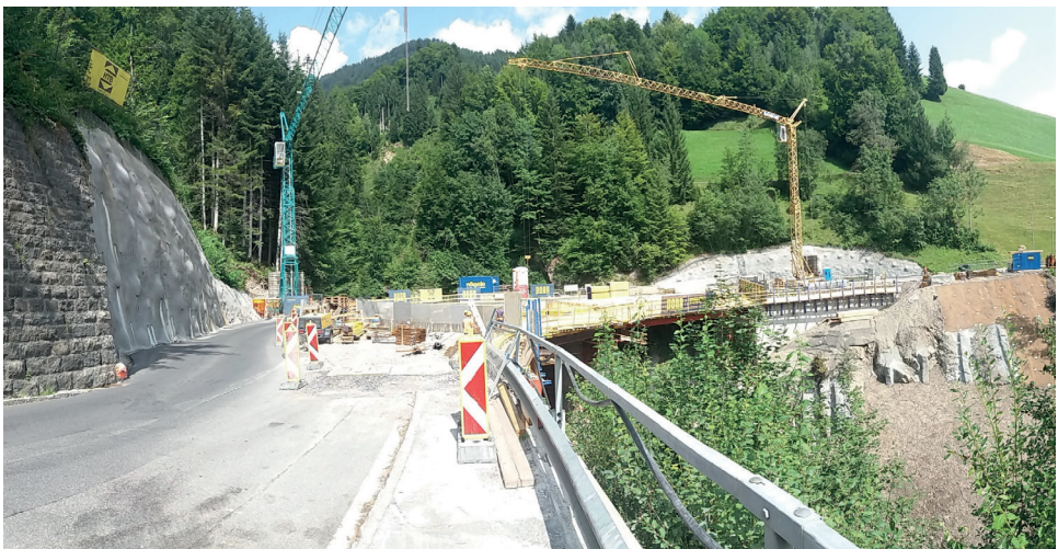
Baustelle Hölltobelbrücke. Foto: Julian Ganahl
