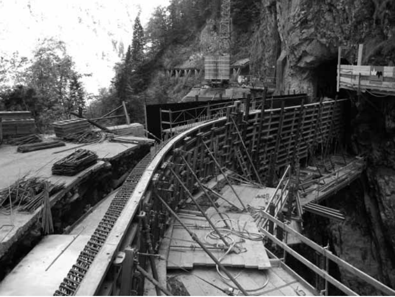
Bauarbeiten an der Straße nach Ebnit
