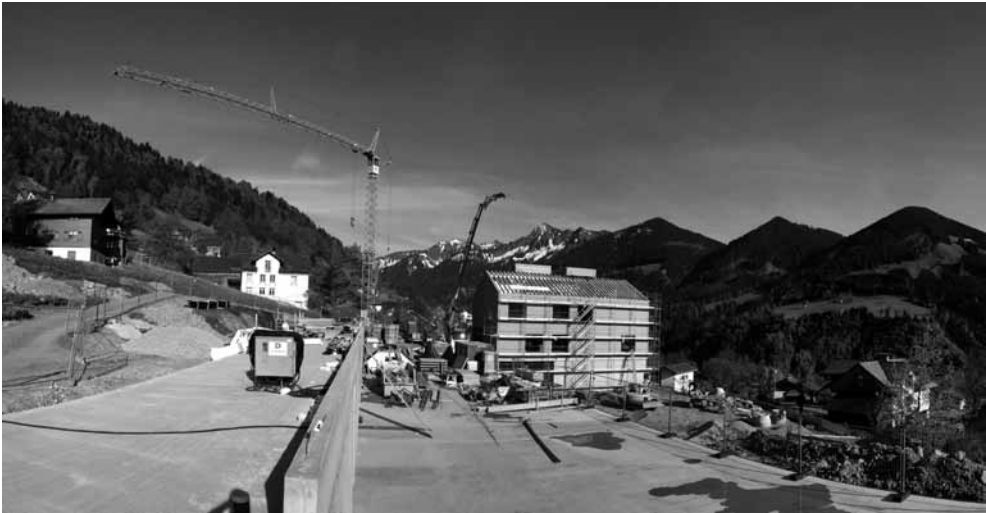
Der Bau der neuen Volksschule mit Mehrzwecksaal schreitet zügig voran. Baustand am 10. Mai 2012.
