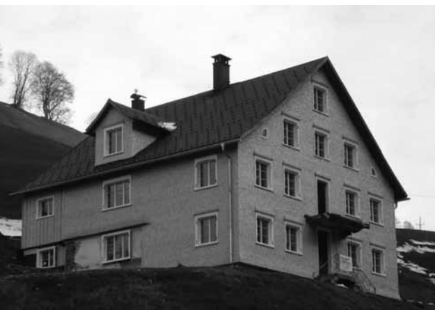
Während das alte Schul- und Mesnerhaus in Marul geschleift wurde, begann die Diözese mit der Renovierung des Pfarrhofes (Foto). Dort sollen im kommenden Jahr mit erheblichem finanziellem Aufwand drei Wohnungen fertig gestellt werden. Foto: Josef Schneider
