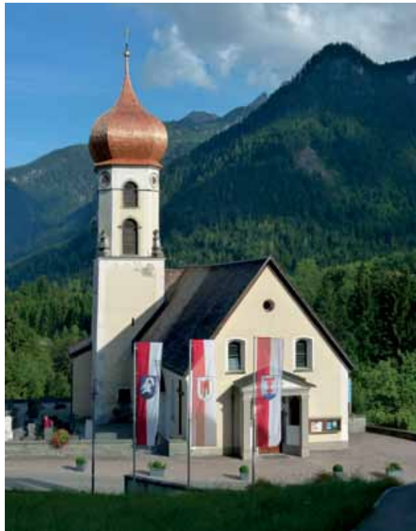
Pfarrkirche Bürserberg mit neuer Turmeindeckung. Foto: Karl Fritsche
